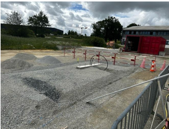
Zone avant réalisation
