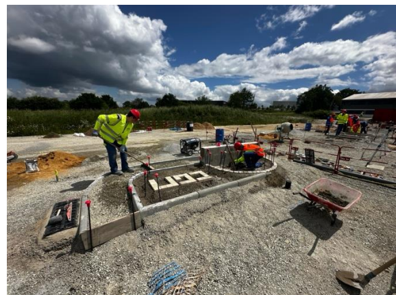
Zone en cours de réalisation
